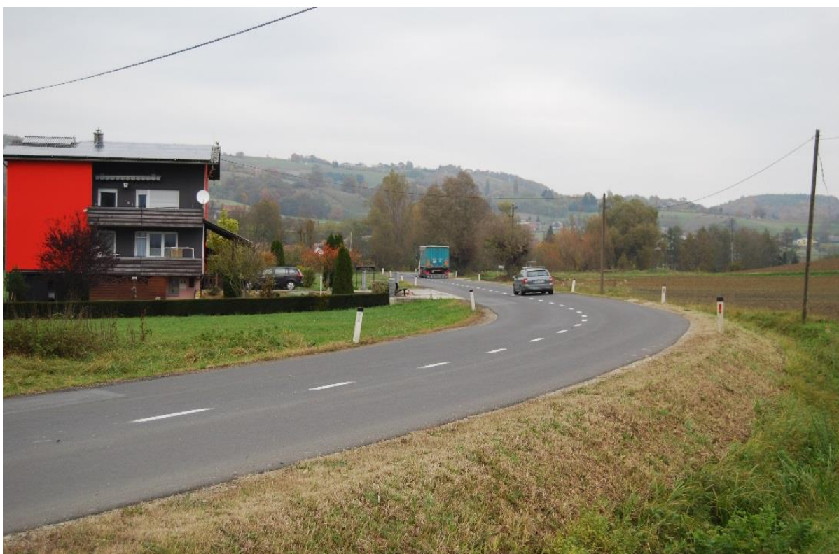
SERDICA – državna cesta brez pločnikov ali kolesarskih poti, prometno zelo obremenjena
